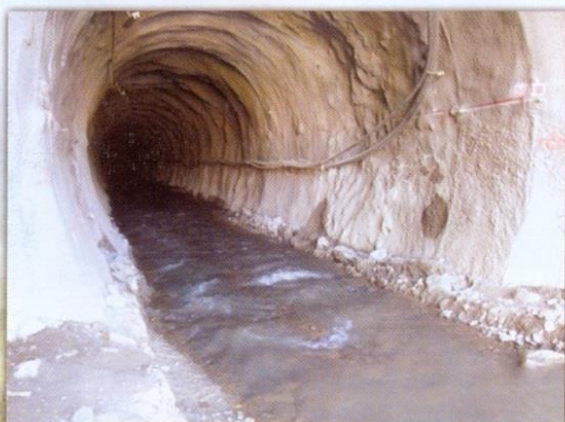
Ingreso del agua a través del Portal de entrada del túnel de desvío
